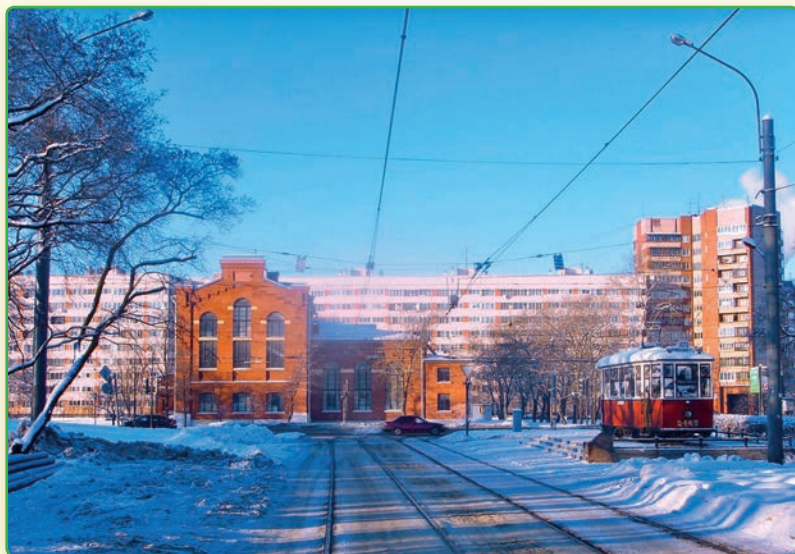
Выезд из трамвайного парка № 8, памятник-трамвай и здание подстанции Оранэлы. Источник: фото автора, 2016 г.
